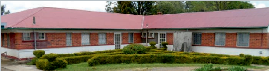
Keňský bohoslovecký seminář tvoří komplex budov různého využití.
