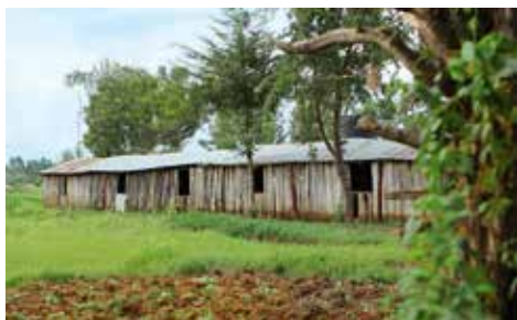
■ Chatrná budova nevydrží poryv větru ani silný déšť.
